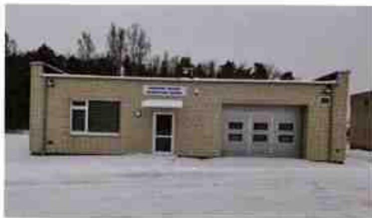
33 pav. Įrengtas sandėliavimo paskirties pastatas (atliekų paruošimui naudoti pakartotinai pastatas)
